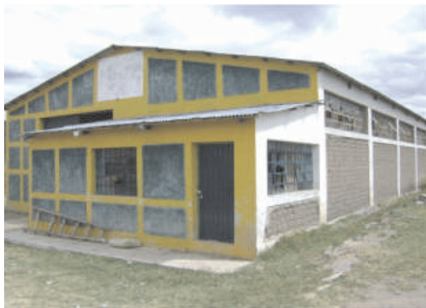
Centro de acopio de Callalli, provincia de Caylloma, Arequipa
