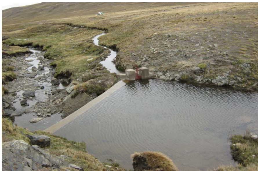
Antauta. Bocatoma de captación de agua.
