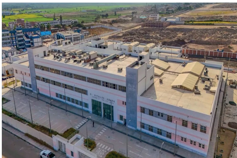
Hospital Maritza Campos. Los gobernadores de la MRS tienen el reto de reactivar las obras paralizadas.
