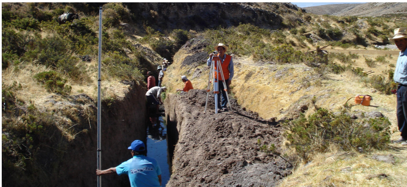
Construcción de canal de concreto en Sacraca, distrito de Puyo - Parinacochas (2008).
