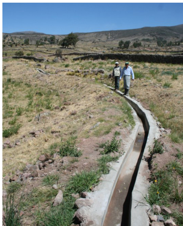
Canal nuevo, vaciado con cemento en Pauza (2011).
