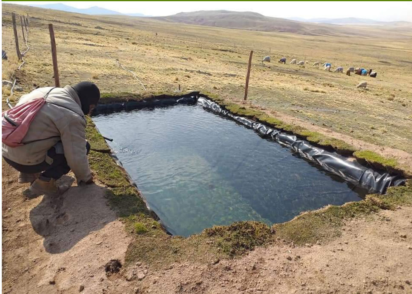
Las familias alpaqueras han construido, con el proyecto, espejos de agua y reservorios de agua para almacenar agua para la época seca.
