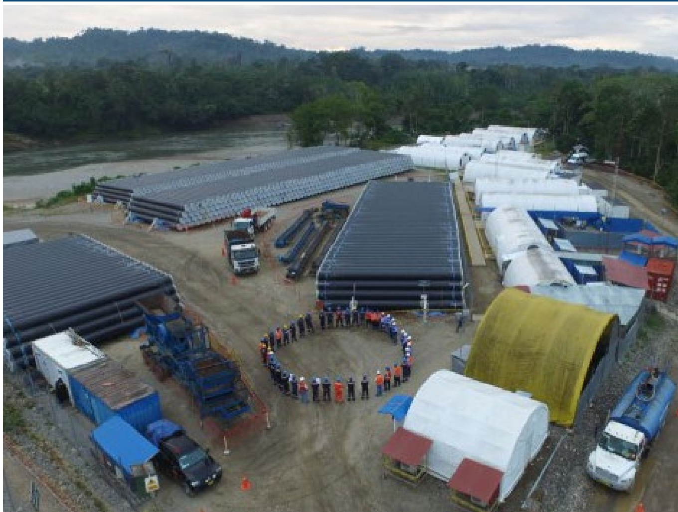
El gasoducto tiene un avance físico del 20%, afirma la empresa Gasoducto Sur Peruano S.A. (Odebrecht) encargada de su construcción.
