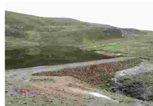
El lado opuesto al agua (espaldón externo) deberá ser cubierto con gramíneas perennes que sirvan de protección contra la erosión por efecto de las lluvias y el viento. Estas gramíneas serán extraídas de algún lugar cercano en bloques de 40 centímetros por lado (champa de chilligua) y colocadas una al lado de la otra hasta cubrir la cara expuesta.
