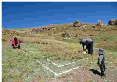
Medición y trazo para la excavación del pozo. Se realiza de acuerdo al plano, debe considerar las siguientes medidas: 7 metros de largo x 4 metros de ancho x 1.50 metros de profundidad, que permitirá el almacenamiento de 30 m<sup>3</sup>. Esta medición se realiza según la cantidad de agua disponible (aforo) del manante de agua.
