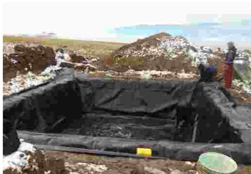
Colocado de la geomembrana, esta manta viene de acuerdo a las medidas del pozo. Su extendido y amoldamiento se realiza para impermeabilizar las paredes del pozo y evitar filtraciones. Los bordes (aleros) del reservorio se deben proteger con terrones de tierra y champas, para evitar el deterioro de la manta de geomembrana por efecto de la intensidad de la radiación solar que llega directamente al suelo durante el día.
