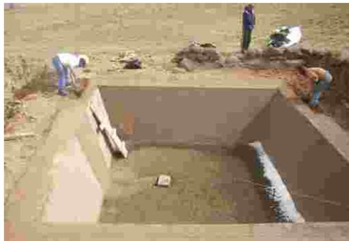
Acabado de las paredes del pozo, se realizará con tierra arcillosa y con mucho cuidado, procurando que tenga un acabado liso sin aristas, que puedan perforar la manta de geomembrana y provoque la fuga de agua reduciendo la vida útil del reservorio.
