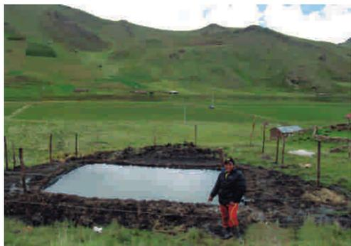
Se recomienda proteger el reservorio con la instalación de un cerco con palos de eucalipto de 1.80 metros de altura y 5 filas de alambre de púa, así se evitará el ingreso y caídas accidentales de animales y personas al pozo.
